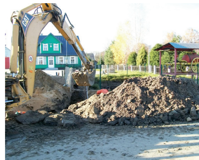
Budowa kanalizacji sanitarnej we wsi Wojszki; całkowity koszt 962 638,13 zł (środek z budżetu gminy); termin wykonania – 31 października 2013 r., kontynuacja inwestycji, wcześniej wybudowana została oczyszczalnia roślinno-stawowa.
