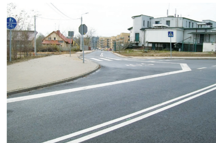
Przebudowa dróg gminnych ul. Leśna, Przejedna i Jeździecka w miejscowości Ignatki-Osiedle; koszt 2 263 229,24 zł; pozyskane środki: 980 952 zł NPPDL (schematowa); termin wykonania – 15 października 2013 r.
