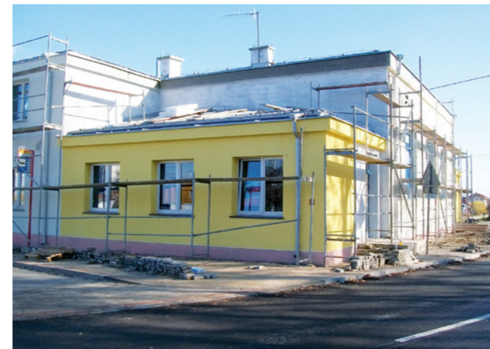
Remont i ocieplenie budynku Ośrodka Kultury w Juchnowcu Kościelnym; całkowity koszt inwestycji 312 999,60 zł; termin wykonania – 15 listopada 2013 r.; środki unijne: 130 742 zł.
